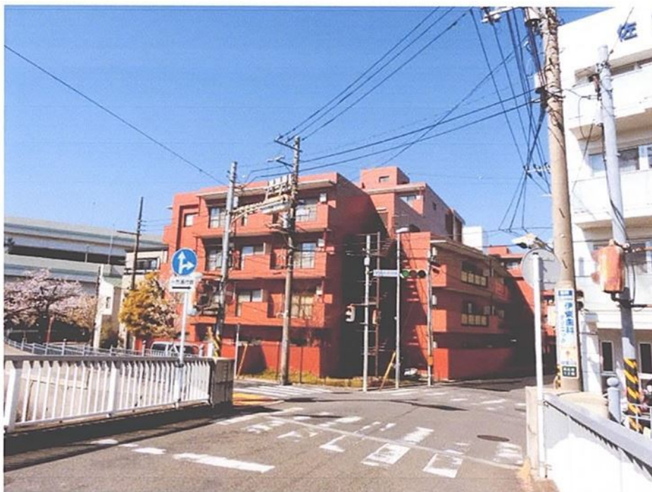
物件 1 の存する一棟の建物
